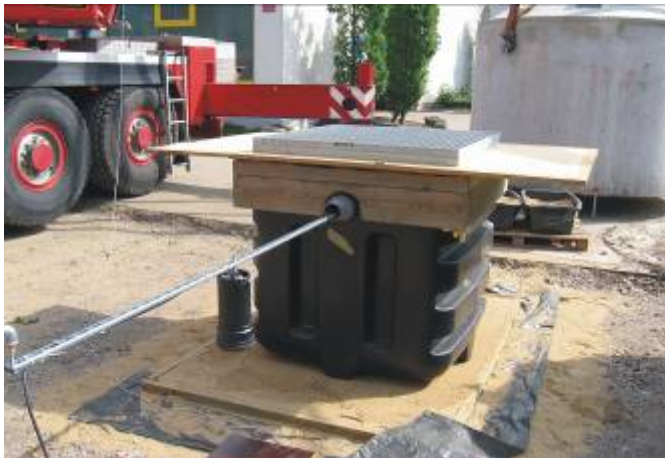
Montage de la ligne de test
